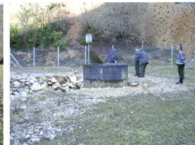
Forage de La Castinière
