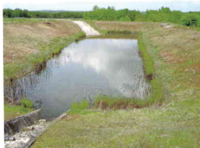
Bassin le plus au sud
