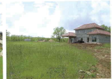
Maison individuelle en construction
